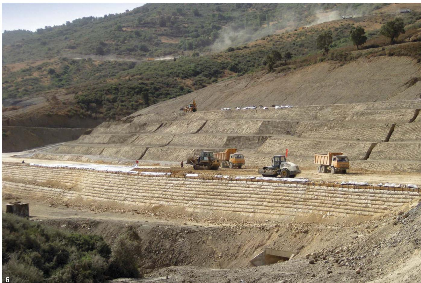
brutales dans les versants de la section. Les lits de renforcement intégrés au massif améliorent les caractéristiques mécaniques des matériaux de remblai ; le dimensionnement adopté permet de justifier la stabilité interne de ces massifs. La stabilité générale est examinée en intégrant la nature et l'état du sol de fondation.
