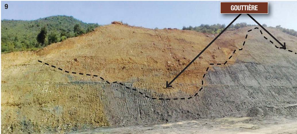
9- Gouttière d'éboulis argileux sur un substratum de schistes argileux de faible résistance (déblais ultérieurement renforcé).
