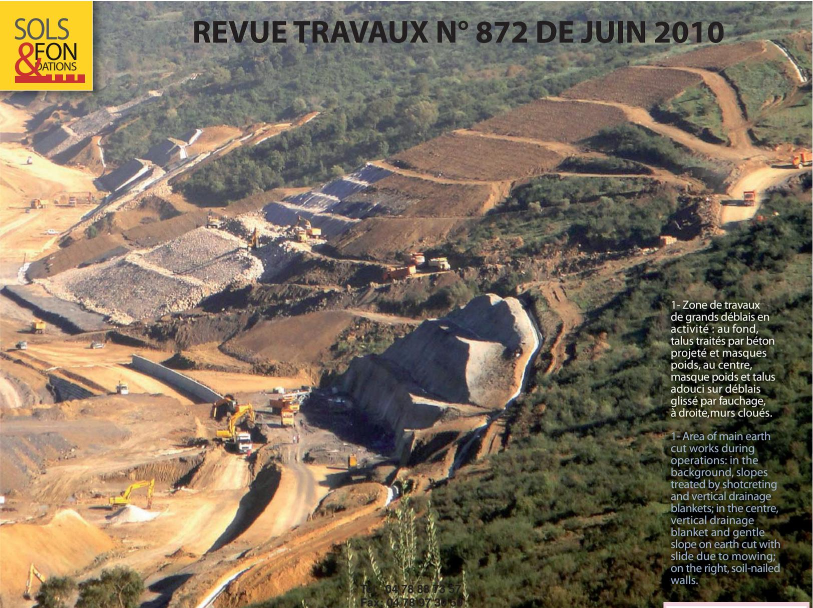
1- Zone de travaux de grands déblais en activité : au fond, talus traités par béton projeté et masques poids, au centre, masque poids et talus adouci sur déblais glissé par fauchage, à droite, murs cloués.
